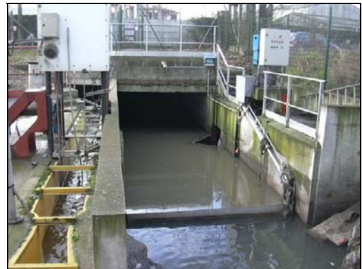
Photo 5 : Vanne clapet
