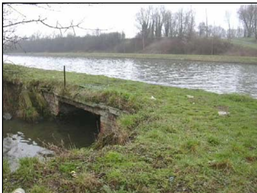
Photo 6 : Confluence dans la canal
