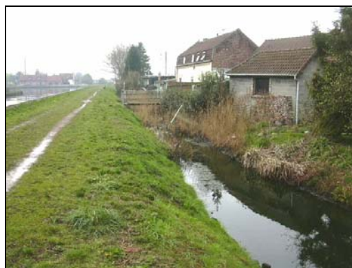
Photo 8 : Rigole de dessèchement en bordure du canal de Beuvry
