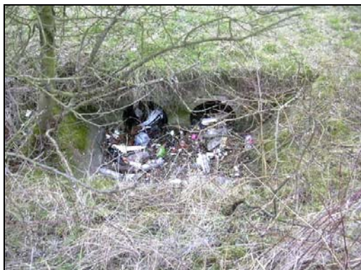
Photo 22 : Passage busé à la confluence du Fossé dans le canal
