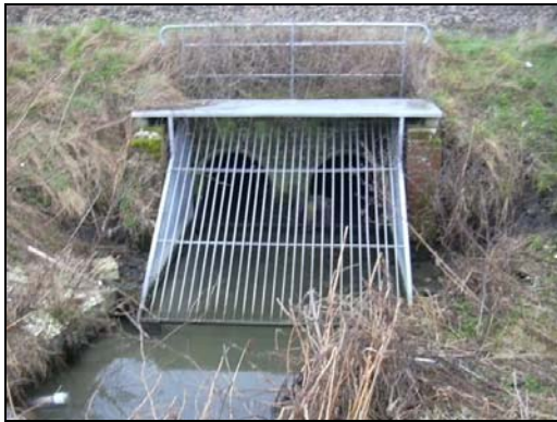
Photo 10 : Confluence de la Fontaine de Bray dans le canal
