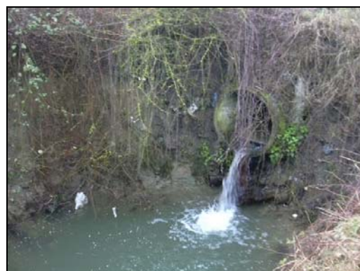
Photo 15 : Perte de charge importante sur le Courant de Drouvin
