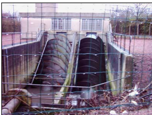
Photo 3 : Vis de relevage de Beuvry
